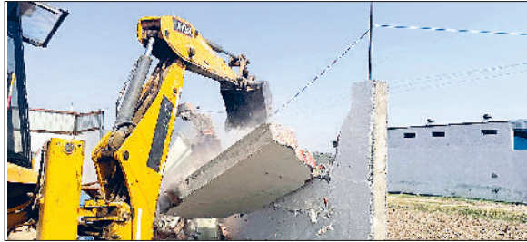
अंबाला। अवैध निर्माण को ढहाती जेसीबी।
